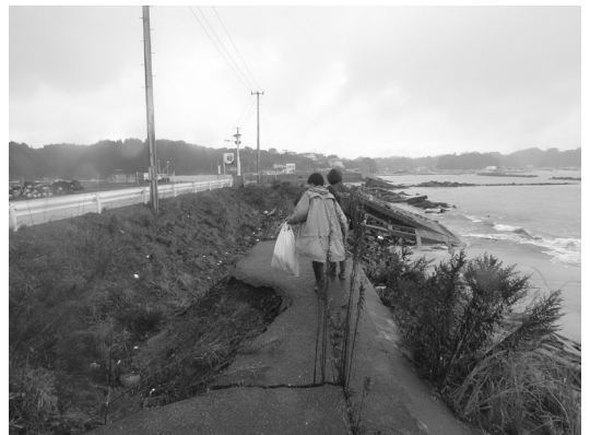
図9．長須賀海岸での採集。防潮堤工事が入り植生は消失した。2013年10月23日 鈴木卓也氏撮影。
